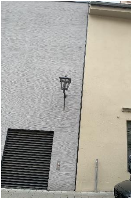
Abb. 32: Übergang Bavariathek zu Ostengasse 5
