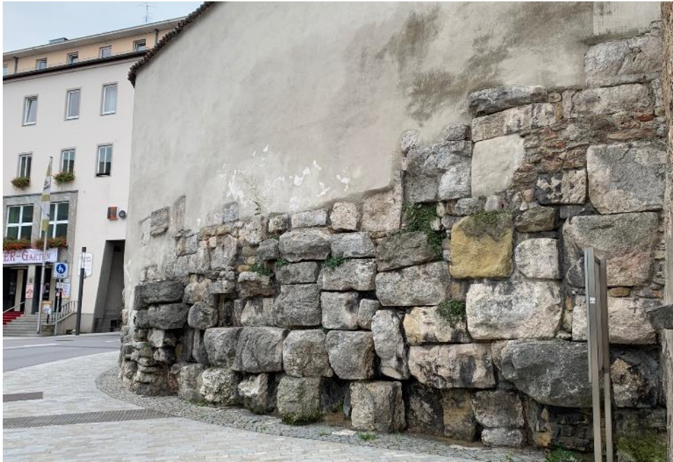
Abb. 29: Wand, Castra Regina, Reste Befestigungsmauer, Regensburg
