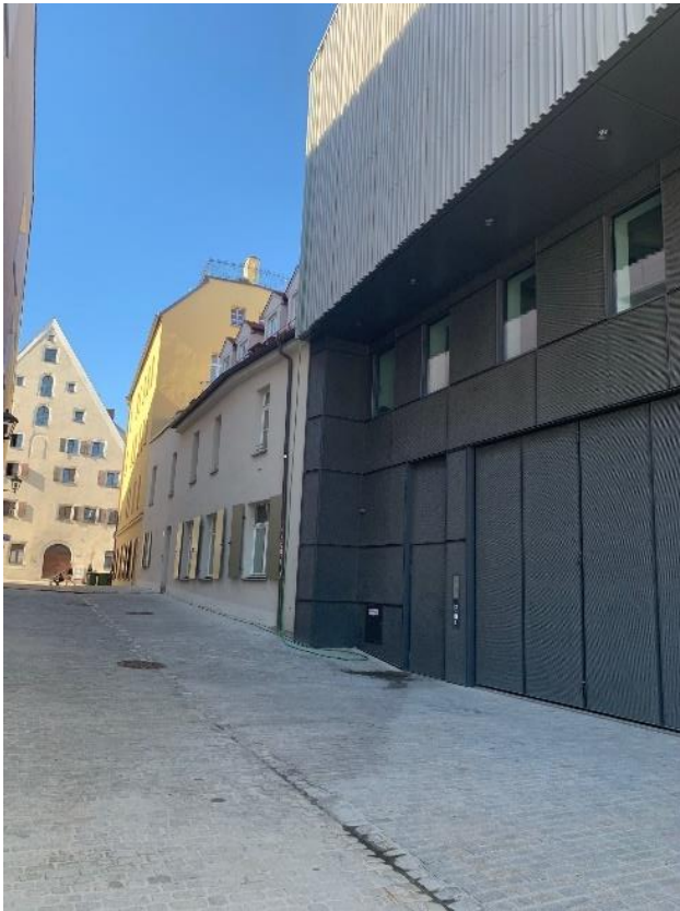
Abb. 33: Stefan Traxler, Museum der Bayerischen Geschichte, Ostfassade, Anlieferung, 2019, Regensburg
