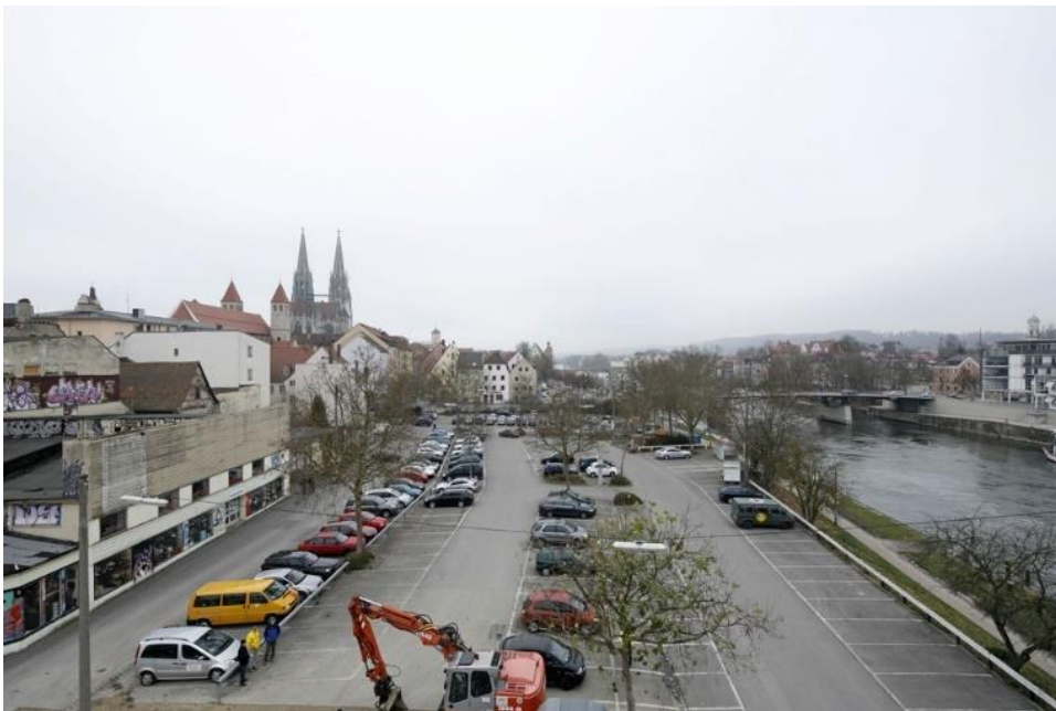
Abb. 34: Parkplatz am Donaumarkt, Regensburg
