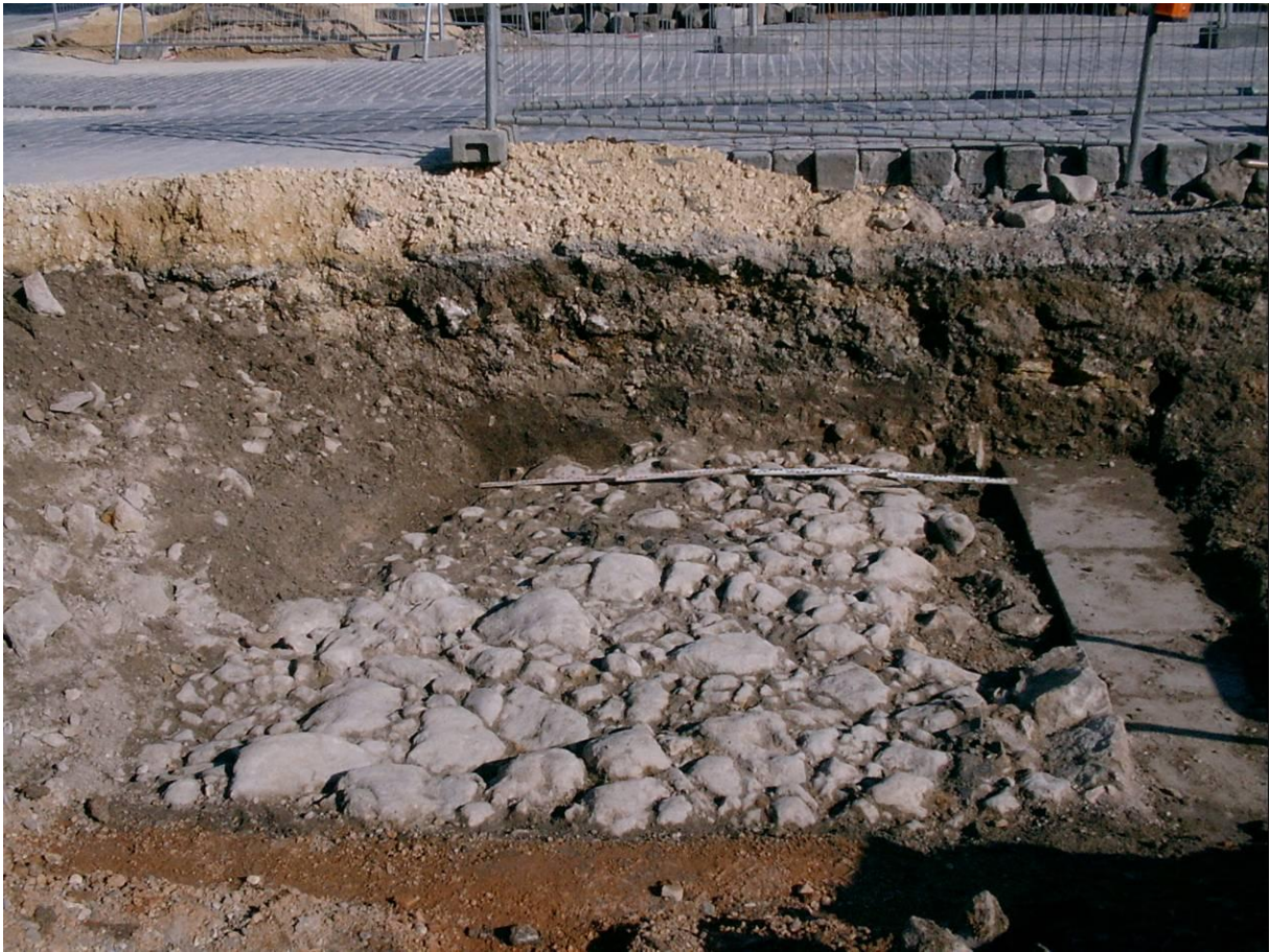
Abb. 13: Bauzeitliches Pflaster im Bereich des Schwarzen Turmes.
