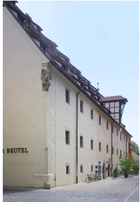
Leerer Beutel nach der Sanierung
