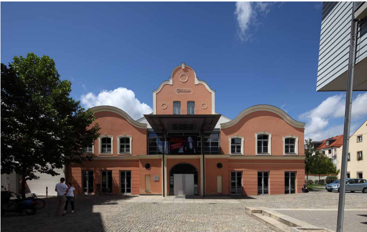
Innenraum vor der Sanierung (oben) und Fassade nach der Sanierung (unten)
