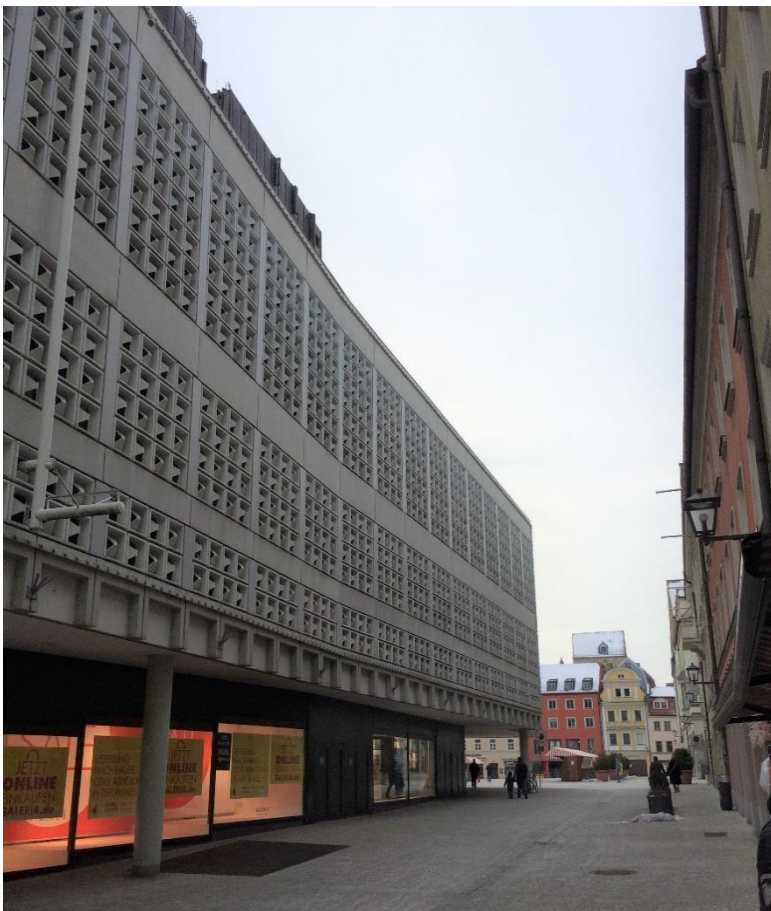
Abb. 6: Nordfassade des Galeria Kaufhof mit Horten-Kacheln in der Drei-Helm-Gasse, Blick Richtung Westen, Januar 2021
