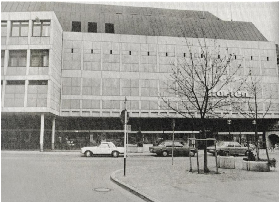
Abb. 9: Südfassade, Kaufhaus Horten, Rasterfassade, nach 1972
