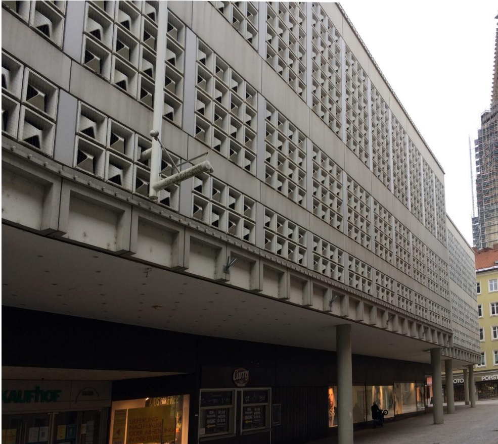
Abb. 8: Ostfassade des Galeria Kaufhof mit Horten-Kacheln in der Pfauengasse, Blick Richtung Norden, Januar 2021
