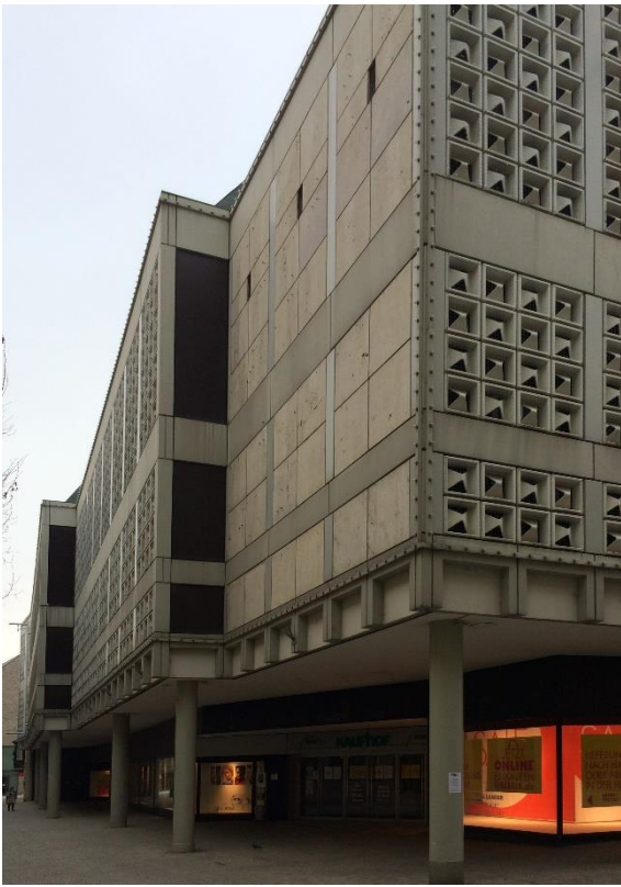
Abb. 17: Ostfassade mit Vorsprüngen und Horten-Kacheln, Pfauengasse, Blick Richtung St. Kassiansplatz, Januar 2021
