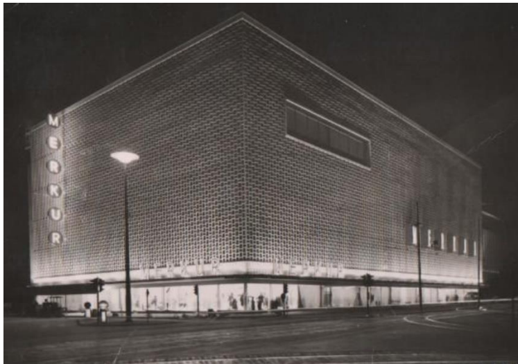
Abb. 21: Galeria Kaufhof in der Düsseldorfer Straße 32 in Duisburg, historisches Foto, nach 1958
