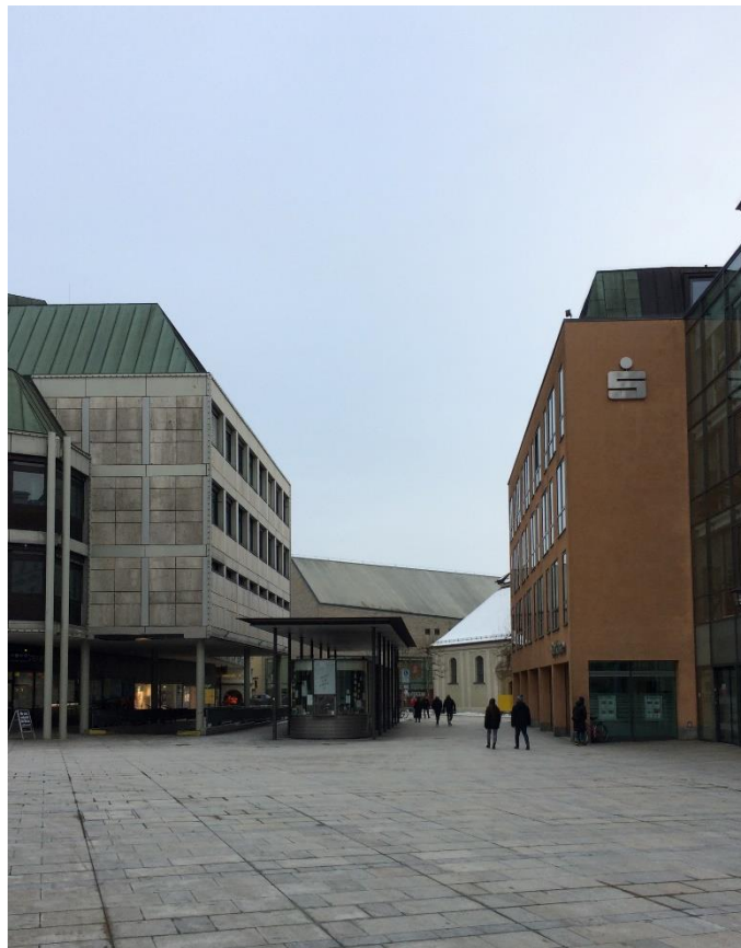
Abb. 11: Galeria Kaufhof, vorspringender Gebäudeteil der Südfassade, gegenüber das Sparkassengebäude, Januar 2021
