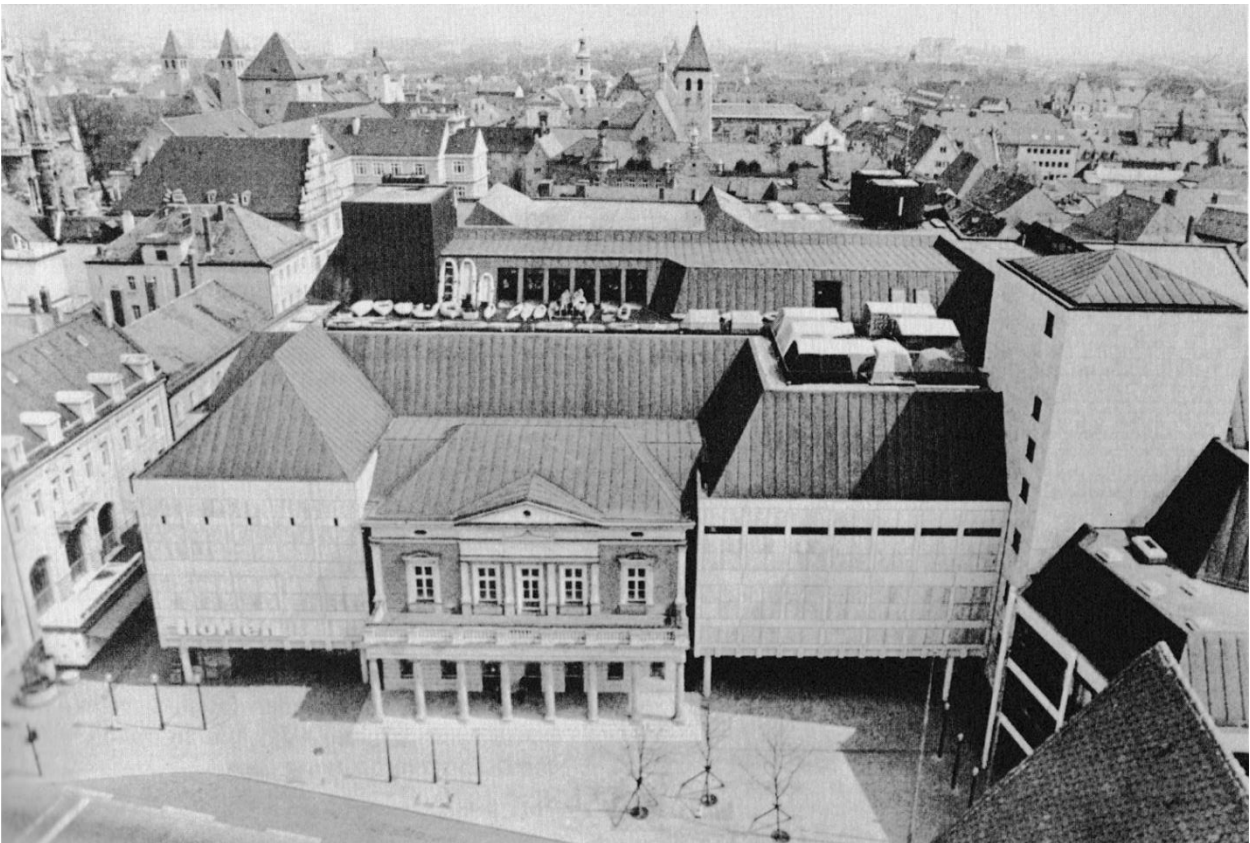
Abb. 5: Westfassade des Kaufhauses Horten mit integrierter Fassade der Alten Wache, Foto nach 1972
