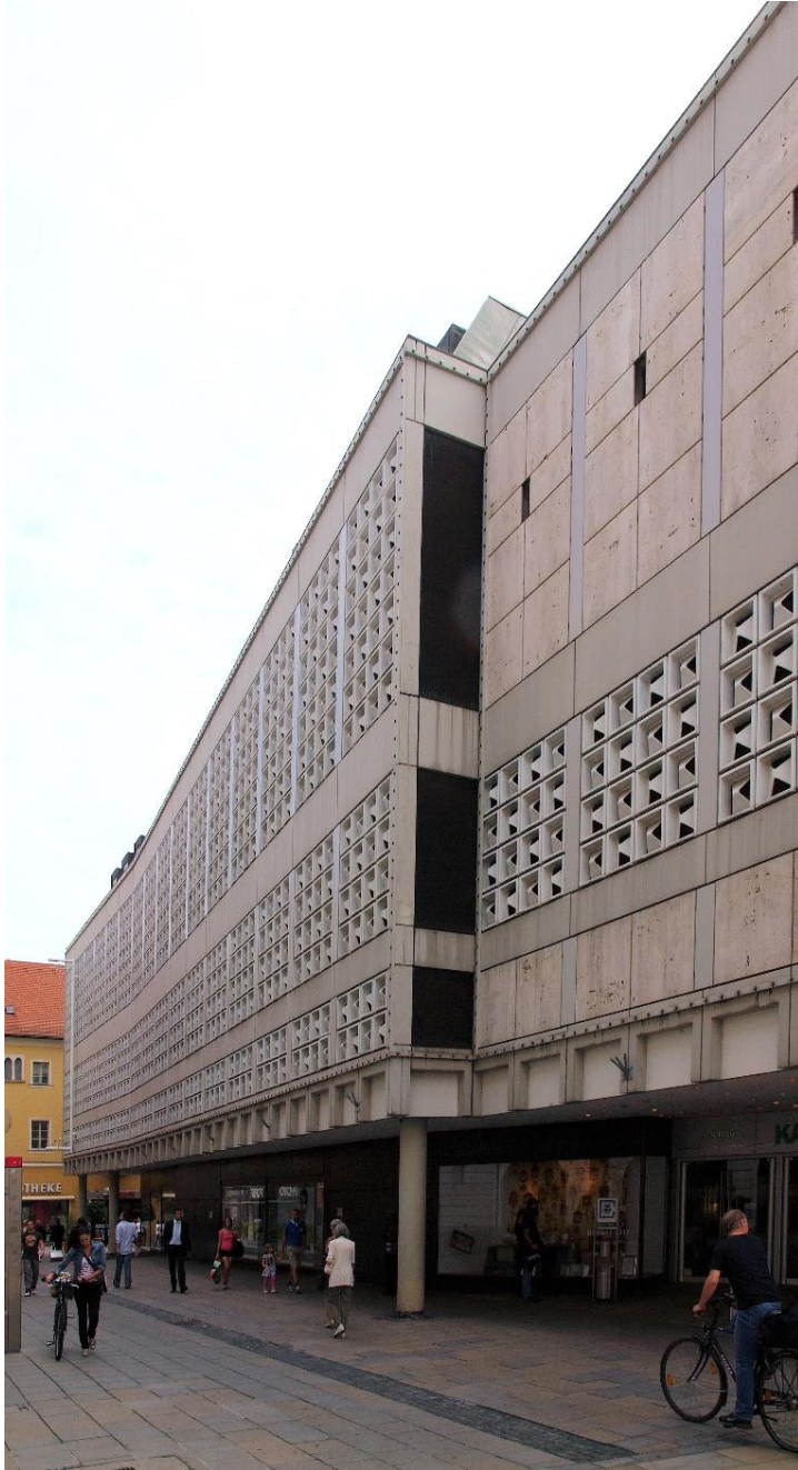
Abb. 7: Nordfassade, Blick Richtung Osten/Pfauengasse, schmaler Streifen mit Horten-Kacheln bei zurückgesetztem Gebäudeteil, voll ausgeprägt bei vorspringendem Baukörper, 2013
