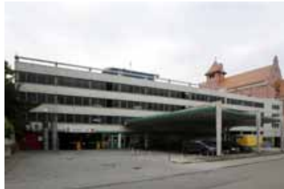
ABB. 14: PARKHAUS ST.-PETERS-WEG 15, NACH NORDOSTEN
